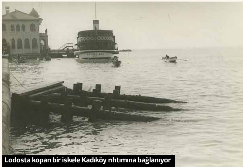
Lodosta kopan bir iskele Kadıköy rihimine bağlanıyor
